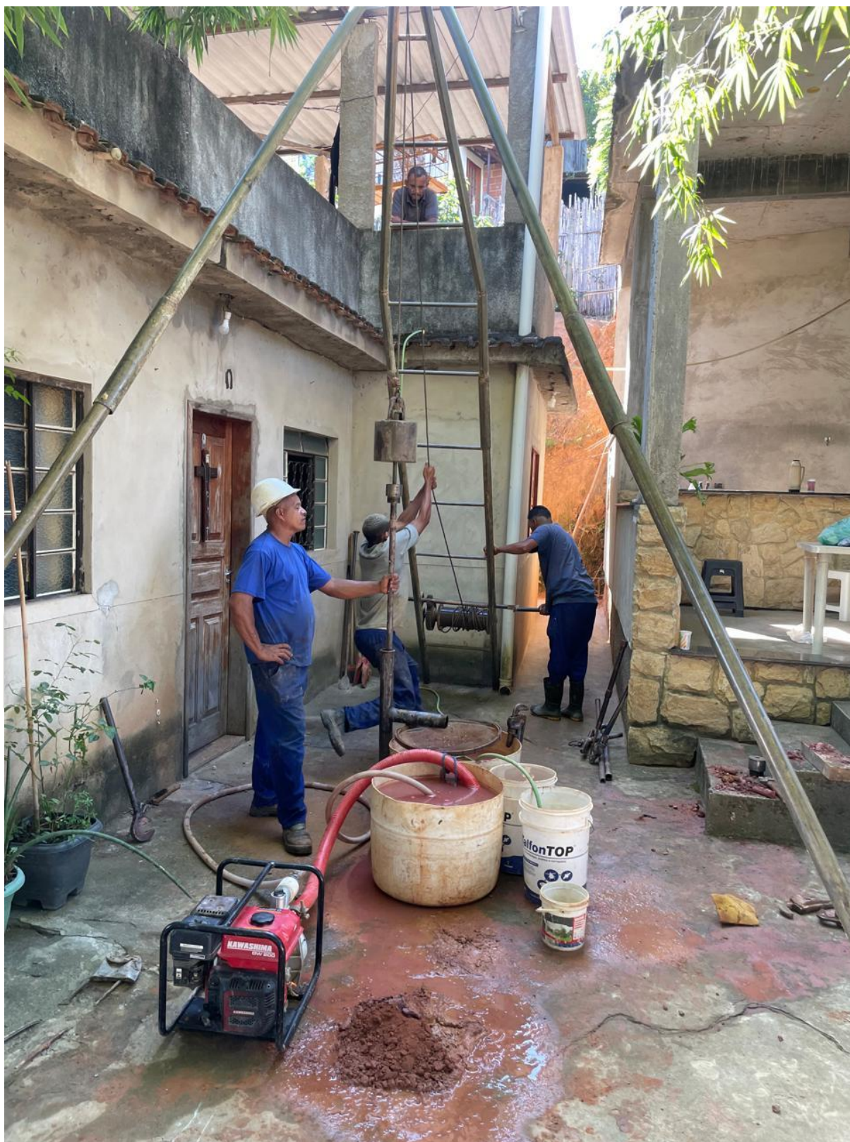
Figura 5 – Execução da sondagem SPT
